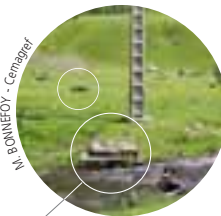
Dégâts causés par le souffle de l'avalanche de 1986 débris de pédiluve à moutons
