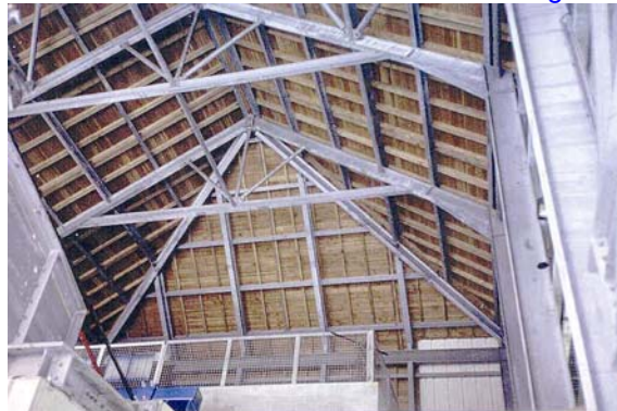
Photo 7-15. Gare du Pic du Midi à la Mongie – vue intérieure
