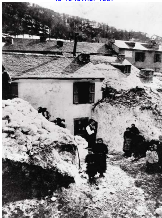
Photo 2-04. Même maison quinze jours après l'accident le 19 février 1897
