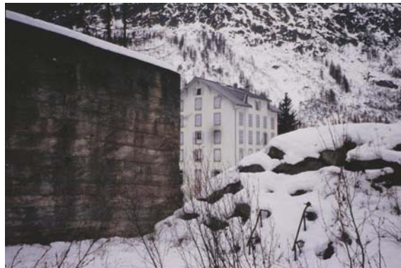
Photo 2-07. L'immeuble du Planet en mars 2002
