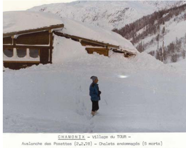
Photo 2-11. Chalets endommagés (5 morts)
