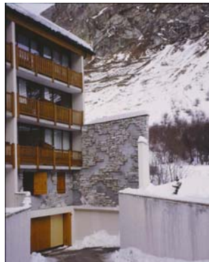
Photo 7-05. Val d'Isère un voile béton face à l'avalanche
