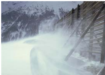
Barrière à vent
